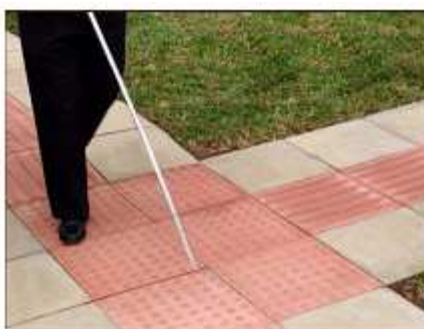
Figura 7: Foto piso Podotátil alerta e direcional
