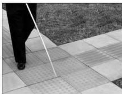
Figura 4: Foto piso Podotátil alerta e direcional
