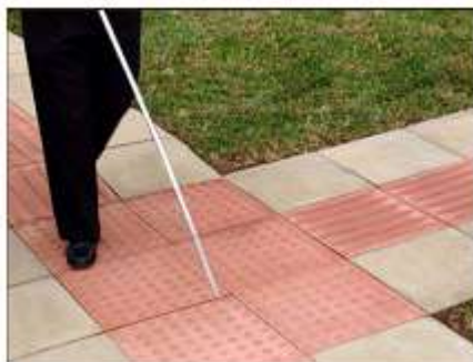
Figura 4: Foto piso Podotátil alerta e direcional
