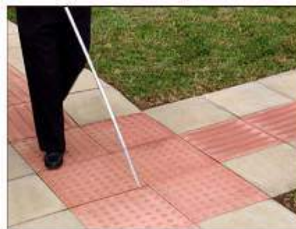
Figura 4: Foto piso Podotátil alerta e direcional
