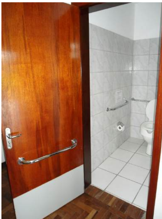
Foto 18: Sanitário NAPNE (barra na porta)
