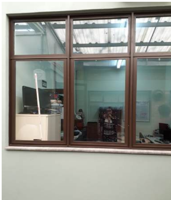
Foto 27: Janela interna NAPNE (abertura para dentro da circulação em altura inadequada)
