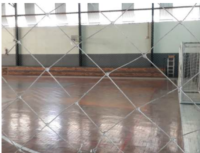
Foto 26: Ginásio (cores de delimitação da quadra pouco contrastantes – desgaste pintura)
