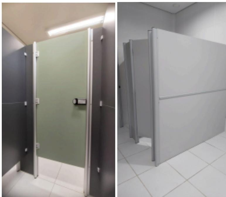
Fig. 3.1 - Divisórias sanitárias e portas em laminado estrutural TS (Alcoplac) + Sistema Neocom - (TECNA e
