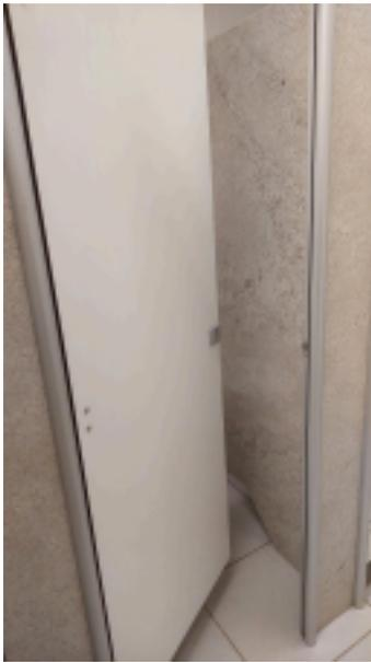
**Fig. 3.3 - Divisórias sanitárias em granito e portas em laminado estrutural TS (Alcoplac) - (IFRS)**
