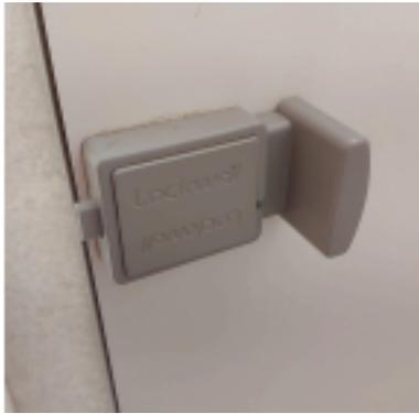
**Fig. 3.5 - Portas em laminado estrutural TS com fecho**
