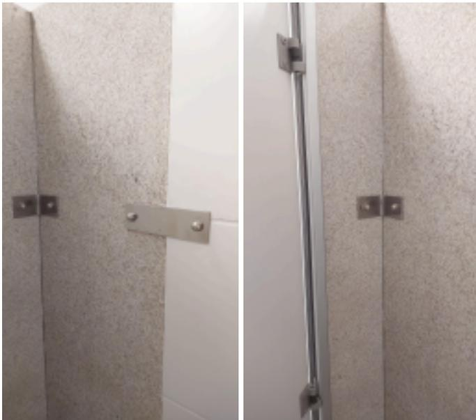
**Fig. 3.4 - Elementos fixadores em aço inox nas divisórias sanitárias em granito - (IFRS)**
