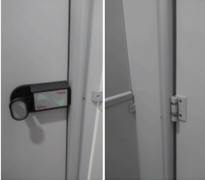
**Fig. 3.2 - Fecho, dobradiças e fixadores no Sistema Neocom - (Adm e TECNA)**
