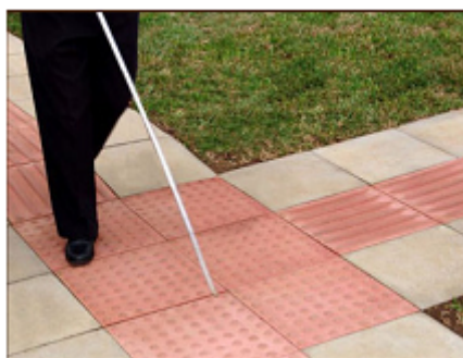
Figura 7: Foto piso Podotátil alerta e direcional
