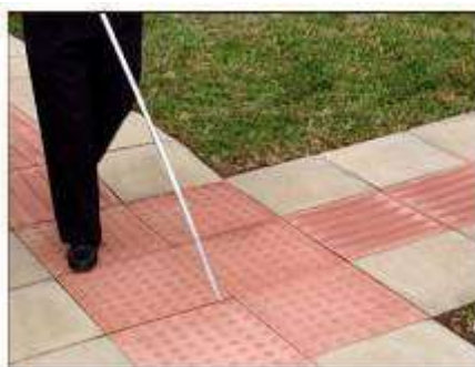
Figura 7: Foto piso Podotátil alerta e direcional
