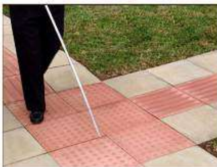
Figura 7: Foto piso Podotátil alerta e direcional
