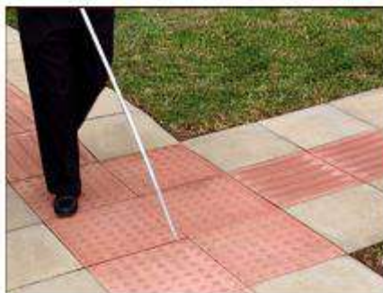
Figura 7: Foto piso Podotátil alerta e direcional
