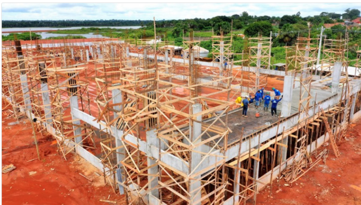
Centro de Convenções em construção / Foto: Marcos Sandes
