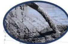
Quando utilizadas reduzem os efeitos da fissuração por retração durante o endurecimento do concreto.
