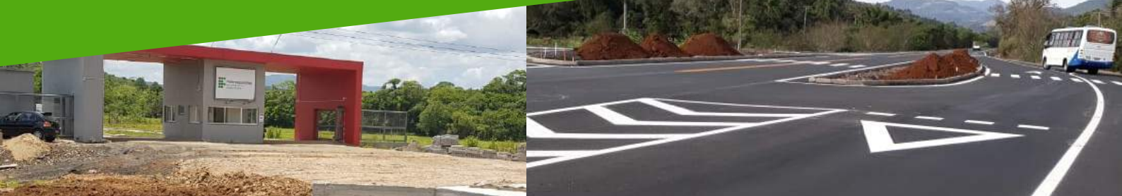
Construção do Acesso Campus Rolante do IFRS, 2018
