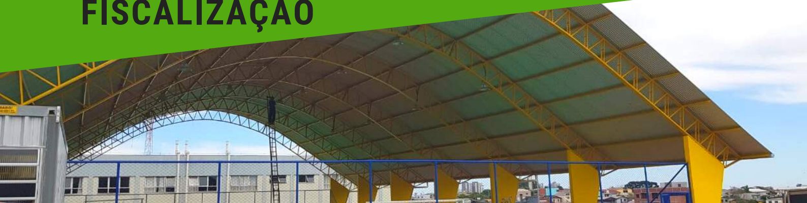
Construção da Quadra Poliesportiva Campus Caxias do Sul do IFRS, 2019
