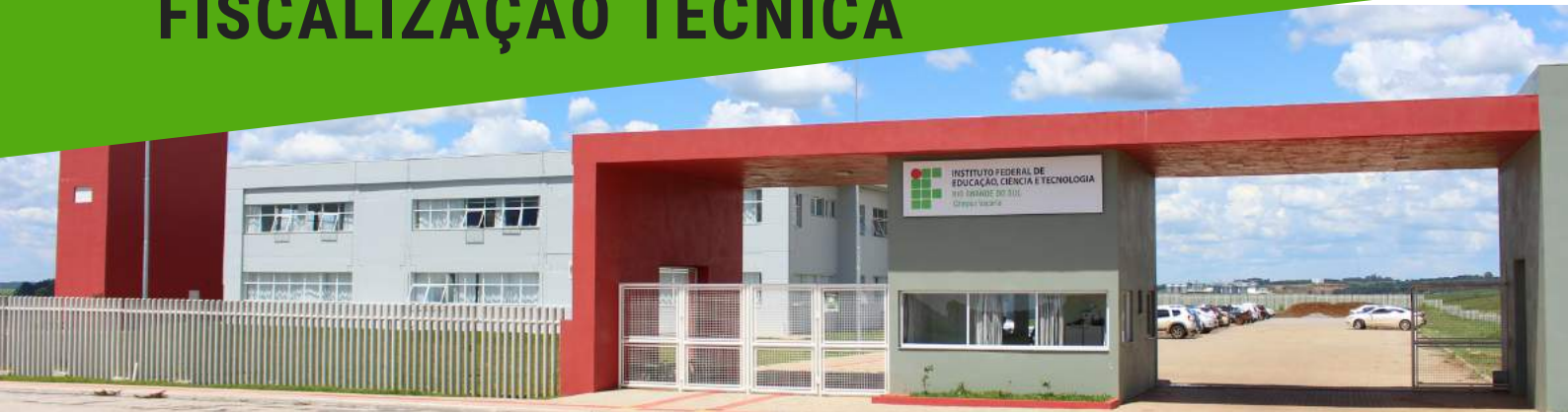
Construção do Pórtico do Campus Vacaria do IFRS, 2015
