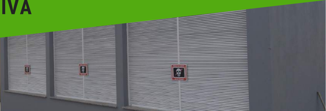
Construção da Subestação Campus Alvorada do IFRS, 2017
