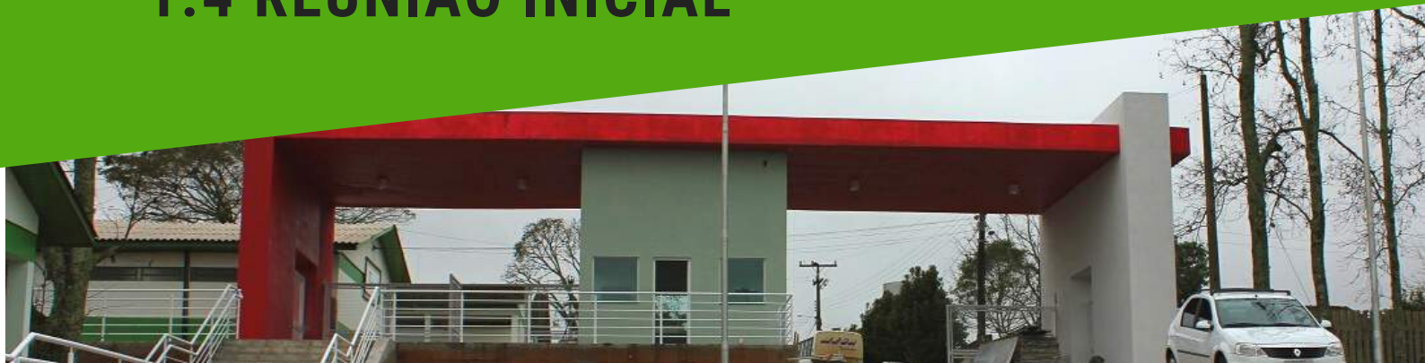
Construção do Pórtico Campus Ibirubá do IFRS, 2016
