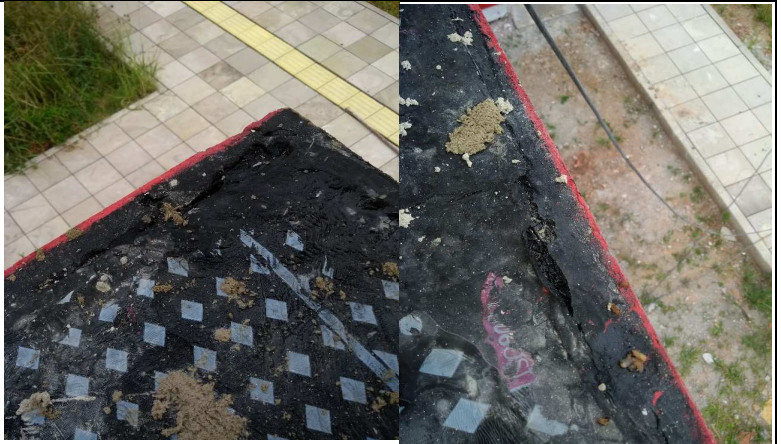
Impermeabilização das marquises.
