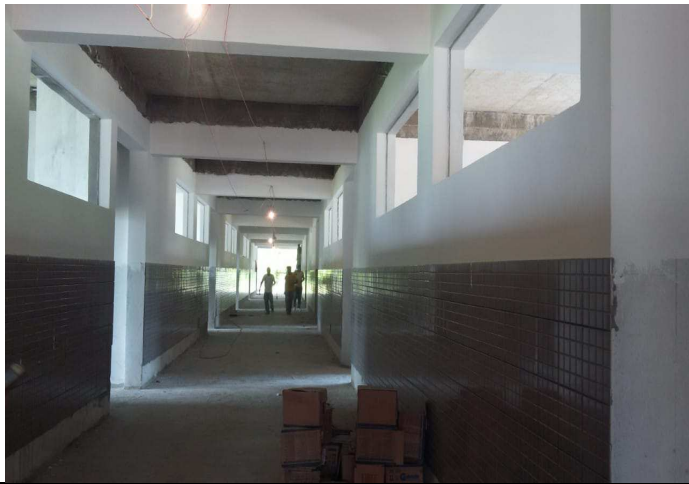
Emassamento e pastilhas no corredor
