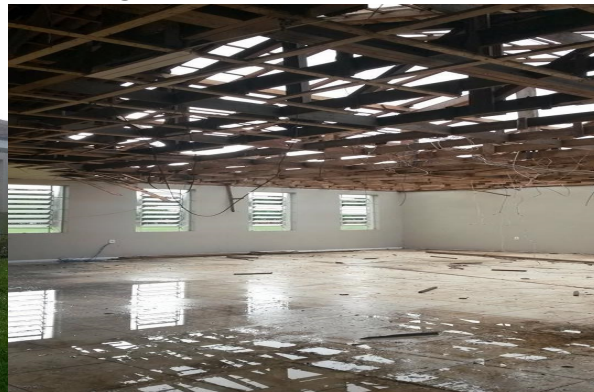
Imagem 2 – Reforma da biblioteca
