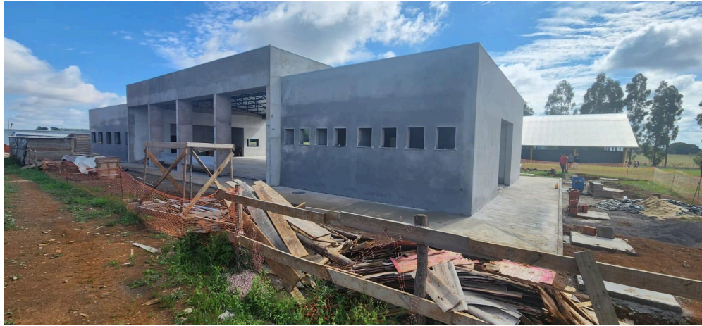
Figura 5: Construção do restaurante.
