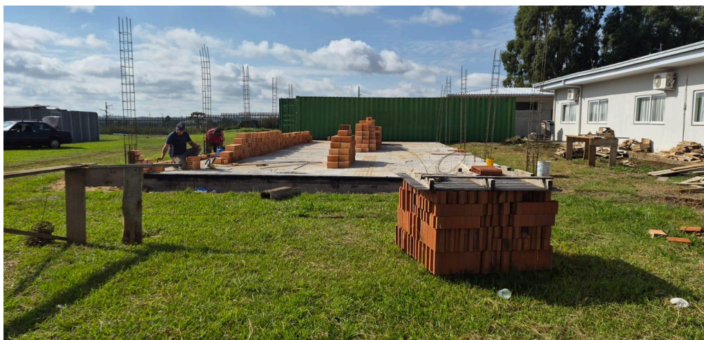
Figura 7: VacaLab em construção (Espaço MAKER).
