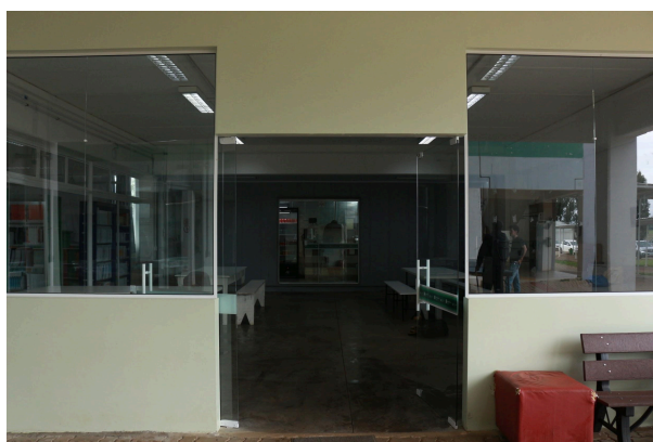
Figura 14: Cantina ao fundo.
