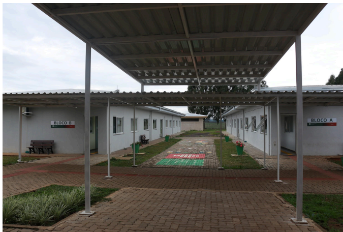
Figura 3: Bloco B (esquerda), Bloco A (direita) e construção do bloco de banheiros (ao fundo) do IFRS Campus Vacaria .
