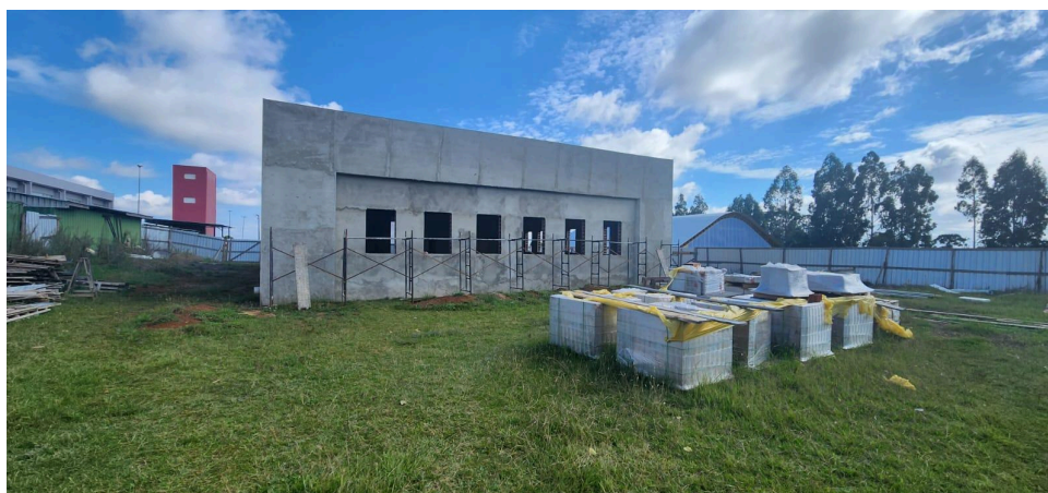
Figura 4: construção da nova biblioteca
