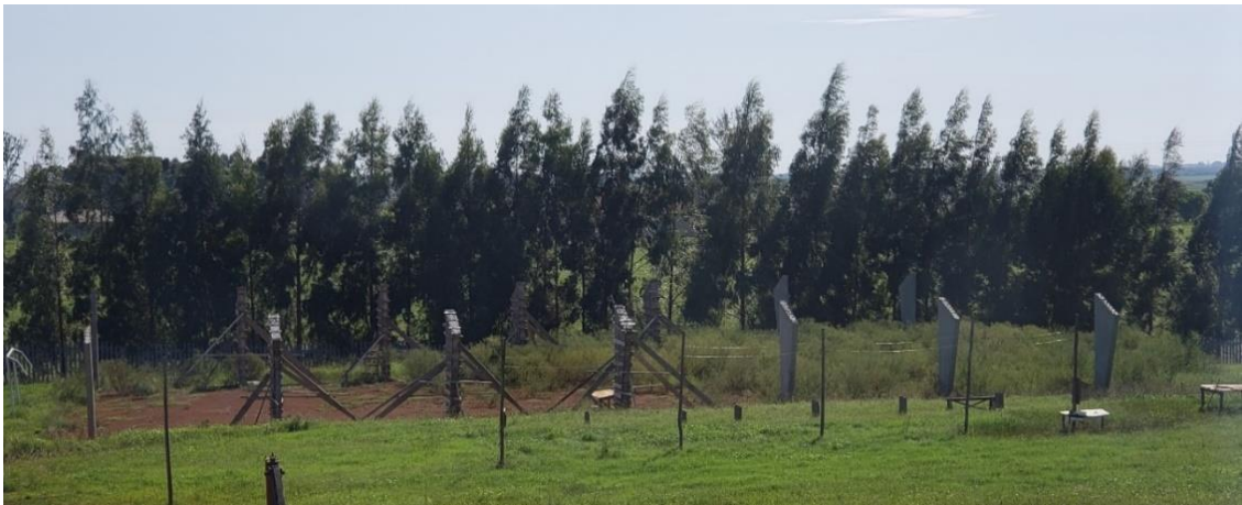
Figura 36: Construção da quadra poliesportiva do IFRS Campus Vacaria.
