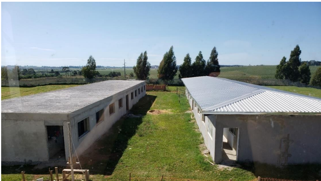
Figura 28: Construção do bloco de laboratórios, do bloco de banheiros (ao fundo) e do bloco didático do IFRS Campus Vacaria .
