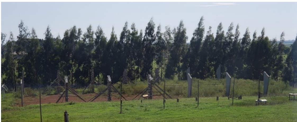
Figura 29: Construção da quadra poliesportiva do IFRS Campus Vacaria.
