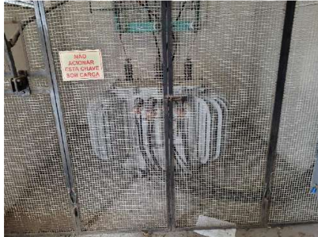
Figura 01 – QGBT atual e Transformador a óleo 225 kVA
