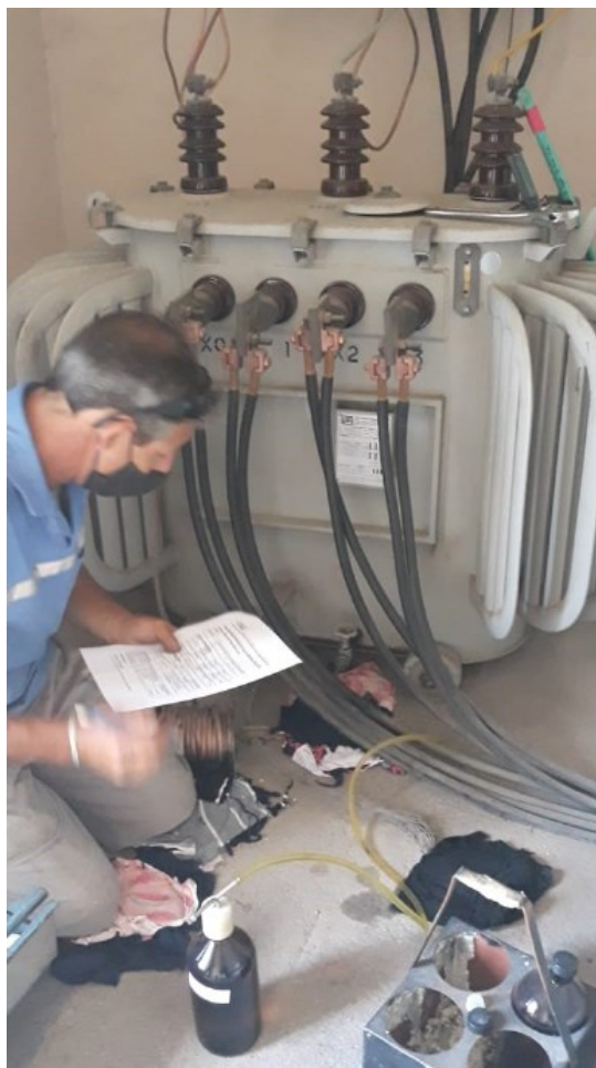
Figura 10 - Manutenção em subestação de energia elétrica
