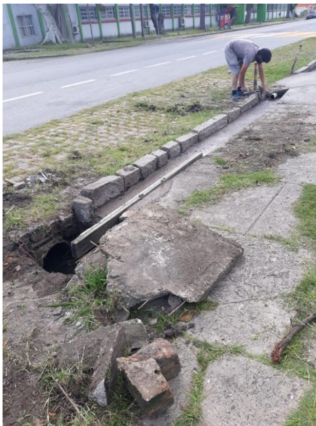
Figura 8 - Manutenção de calçadas e calhas pluviais
