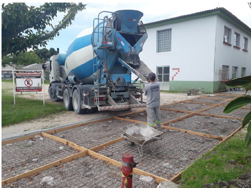
Figura 11 - Manutenção no calçamento do Campus Rio Grande
