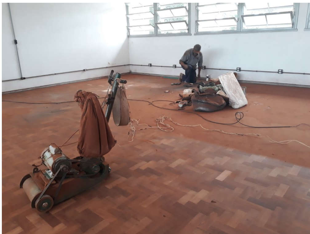
Figura 4 - Ampliação do Laboratório da sala 213, no Pavilhão Central
