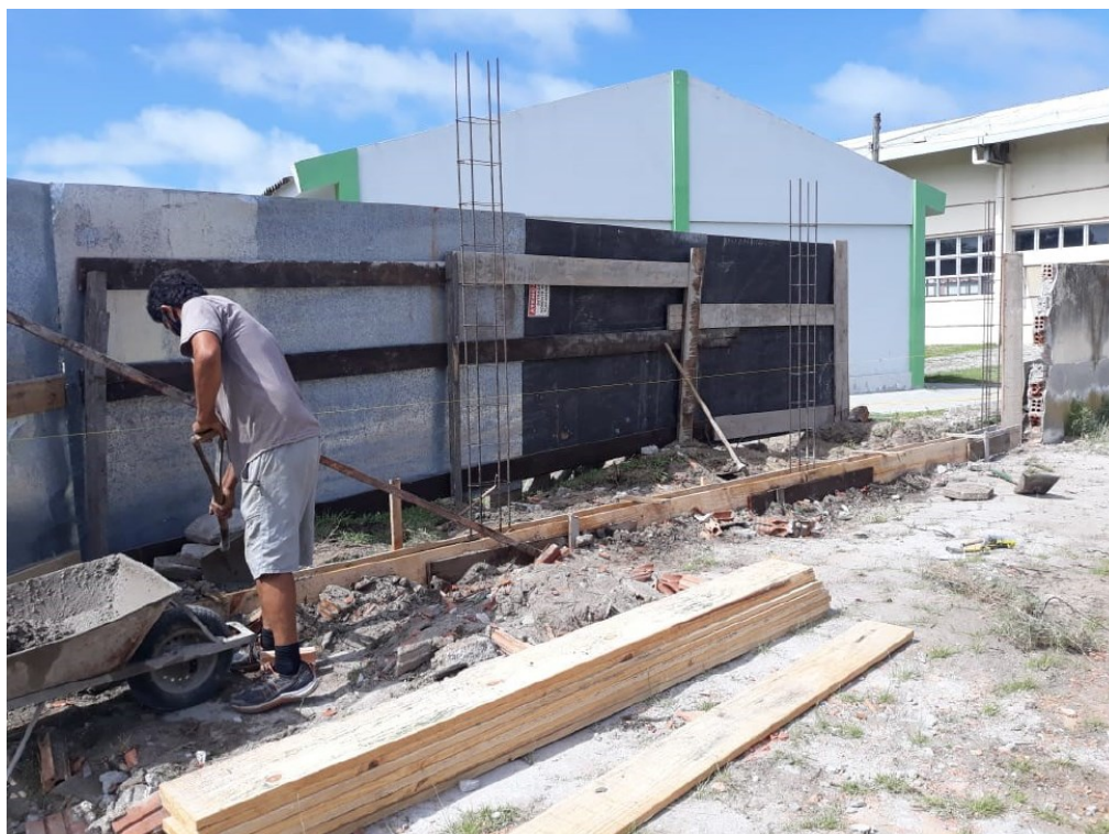
Figura 3 - Reconstrução do muro do Pavilhão 9 e 10.
