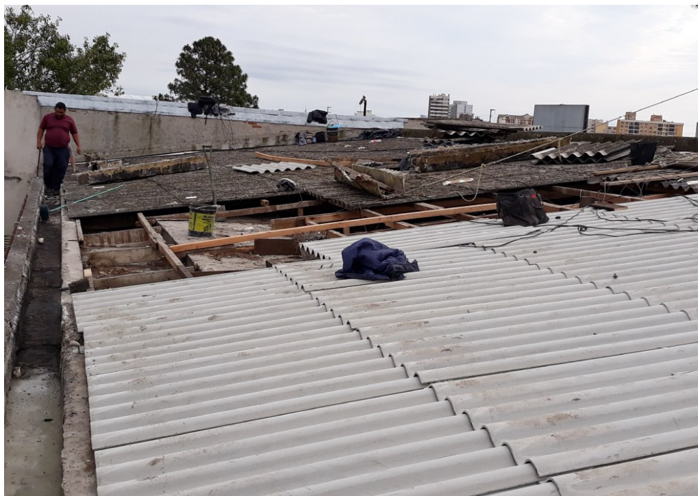
Figura 5 - Manutenção no telhado do Pavilhão Central
