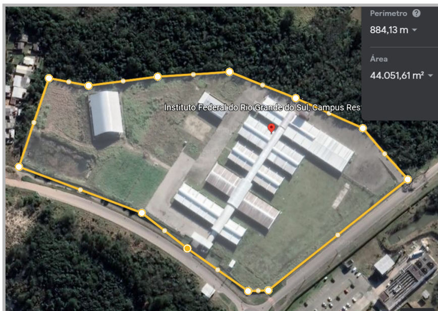
Figura 1 - Área de abrangência do serviço
