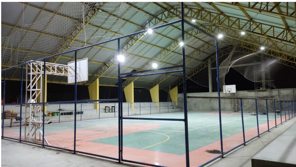
Figura 18 - Obra em andamento: fechamento da quadra poliesportiva.
