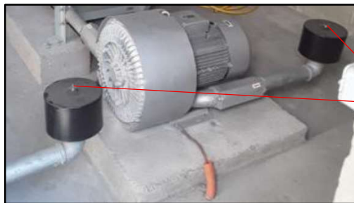
Figura 10. Soprador de ar. Detalhe do suporte do filtro de ar.
