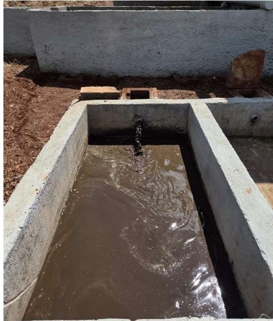
Figura 14. Leito de secagem e aspecto do lodo durante a retirada do tanque de lodo.
