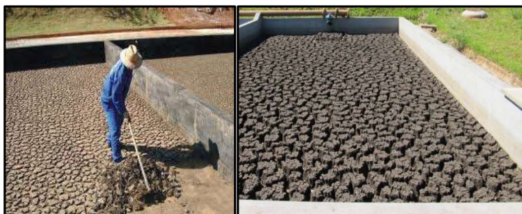
Figura 15. Leito de secagem e aspecto do lodo desidratado.
