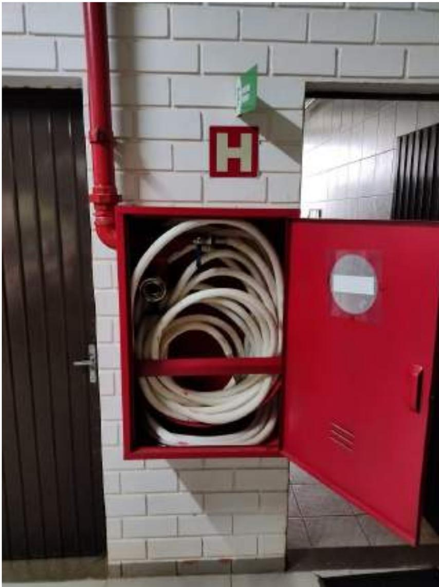
Figura 2: Rede de Hidrante do tipo Mangotinho com conector STORZ
