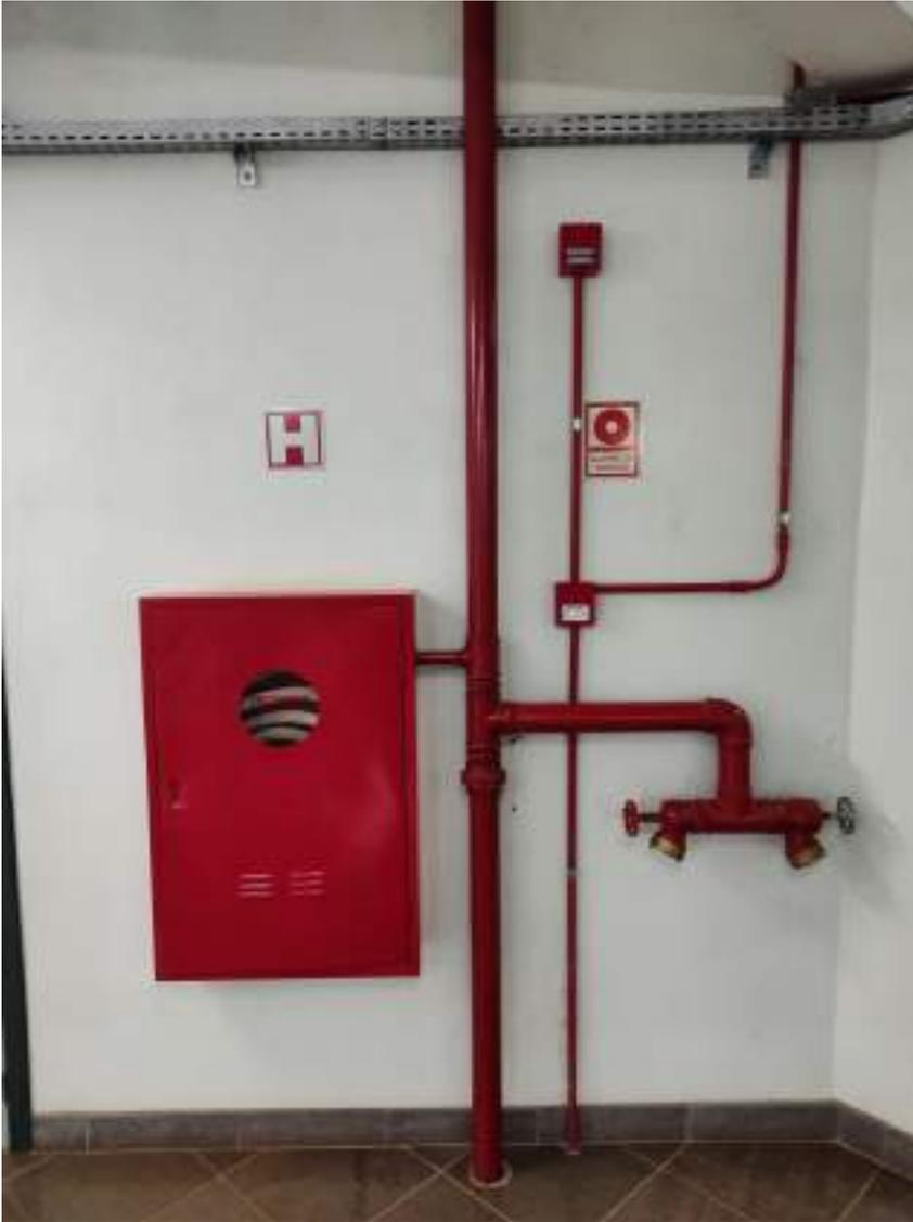
Figura 3: Rede de Hidrante do Tipo 1 - Mangotinho e Rede de Hidrante Duplo do Tipo 2 com 2 SAÍDAS STORZ.
