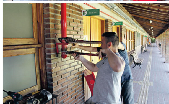
Quase concluído: equipamentos do novo PPCI do Instituto Federal estão sendo instalados por empresa contratada
