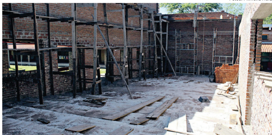
Em construção: novo auditório do Campus Feliz está na fase de construção, devendo ser inaugurado em 2022
