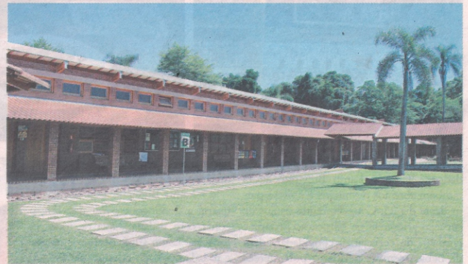
Um dos novos prédios construídos no campus: juntos, os dois blocos abrigam salas de aula, biblioteca, laboratório, sala administrativa, área de convivência e banheiros
