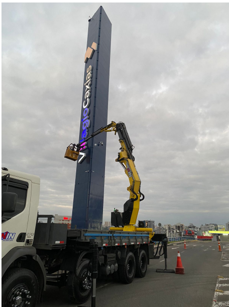
Figura 11. Resultado do projeto técnico de troca de sistema de iluminação no totem Shopping Villagio Caxias.
